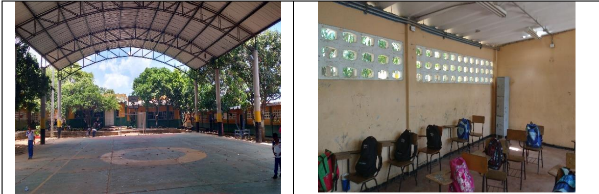
Fotografía 1. Estado actual Infraestructura Educativa.
