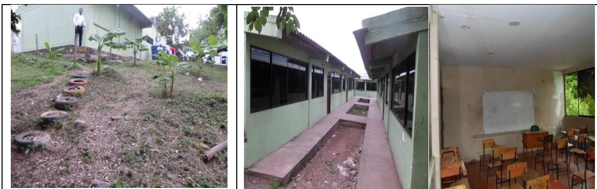
Fotografía 1. Estado actual Infraestructura Educativa.
