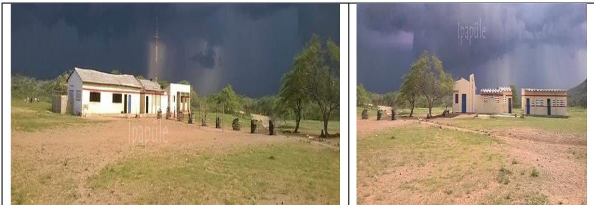
Fotografía 1. Estado actual Infraestructura Educativa.
