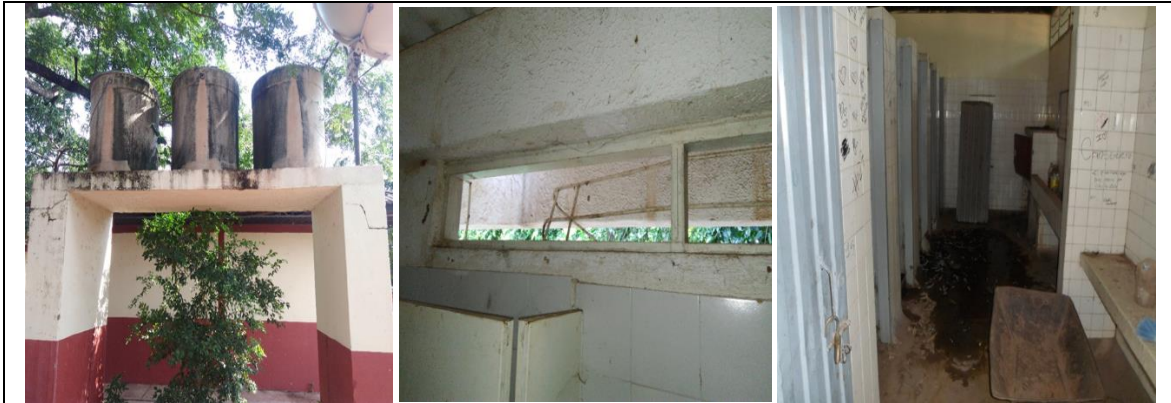
Fotografía 1. Estado actual Infraestructura Educativa.
