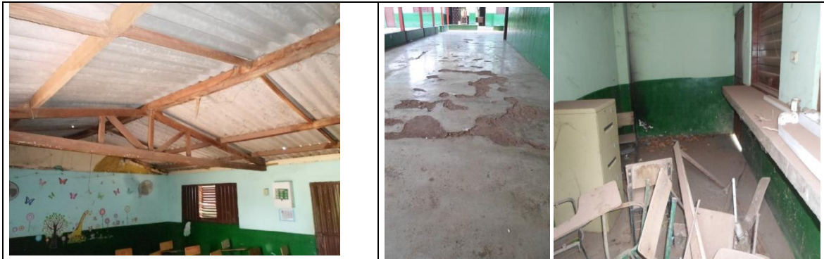
Fotografía 1. Estado actual Infraestructura Educativa
