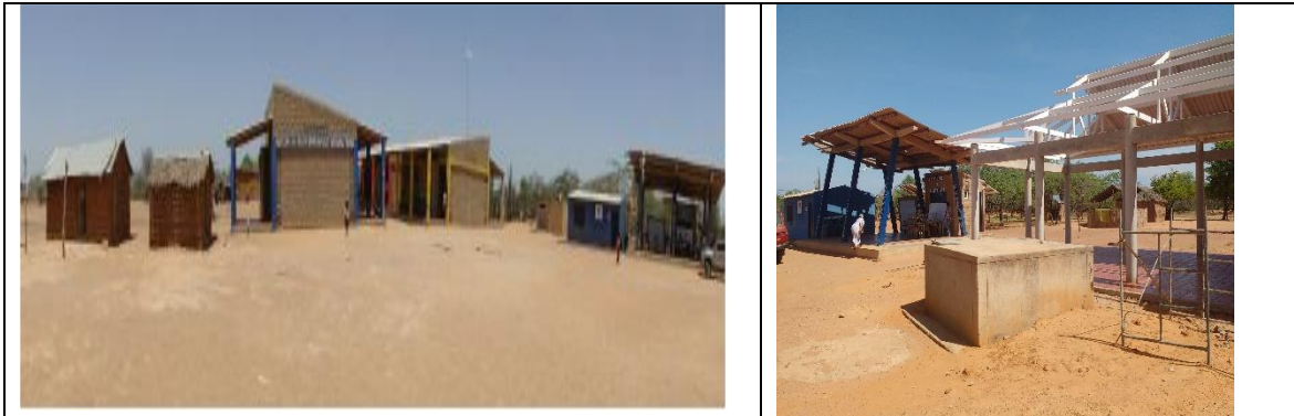
Fotografía 1. Estado actual Infraestructura Educativa.
