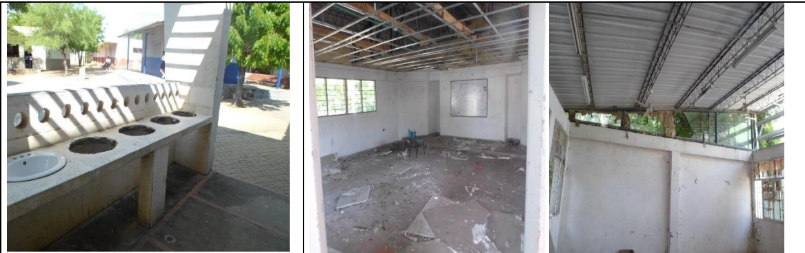
Fotografía 1. Estado actual Infraestructura Educativa.
