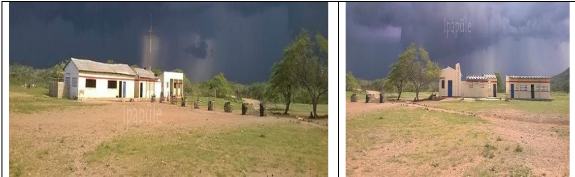
Fotografía 1. Estado actual Infraestructura Educativa.
