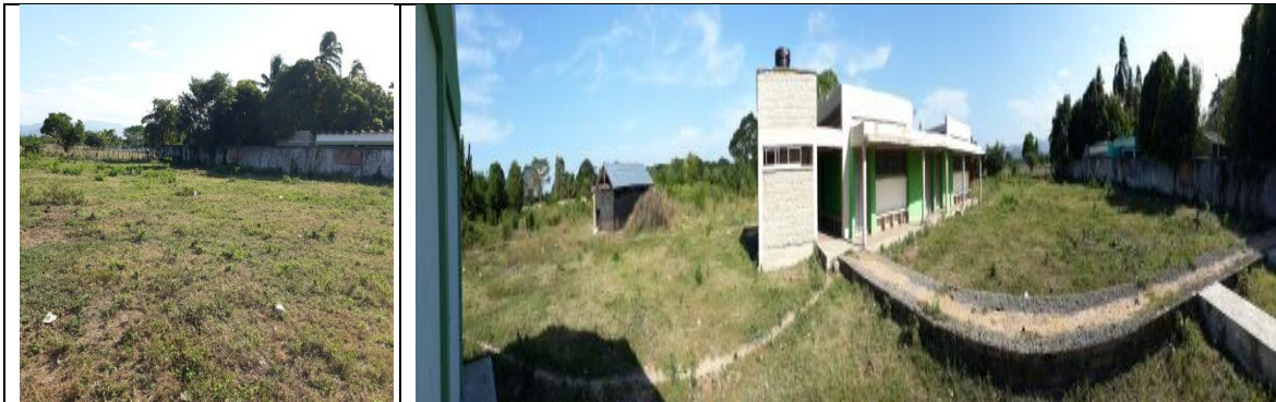
Fotografía 1. Estado actual Infraestructura Educativa.
