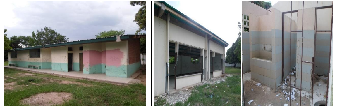
Fotografía 1. Estado actual Infraestructura Educativa.
