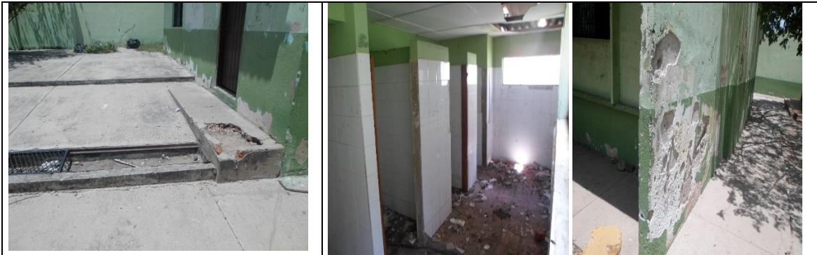
Fotografía 1. Estado actual Infraestructura Educativa.
