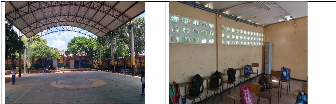
Fotografía 1. Estado actual Infraestructura Educativa.
