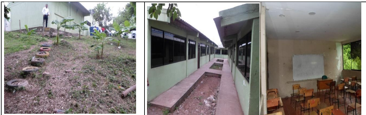
Fotografía 1. Estado actual Infraestructura Educativa.
