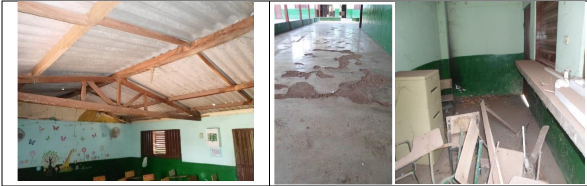
Fotografía 1. Estado actual Infraestructura Educativa
