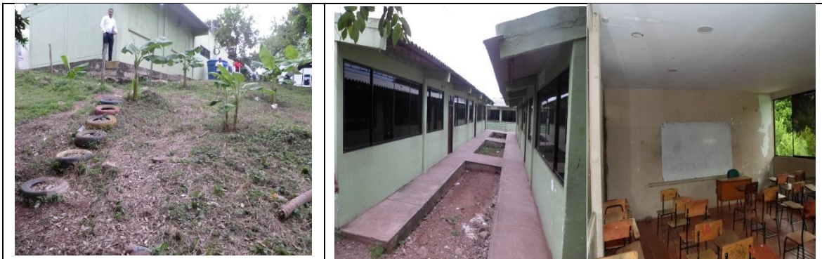
Fotografía 1. Estado actual Infraestructura Educativa.
