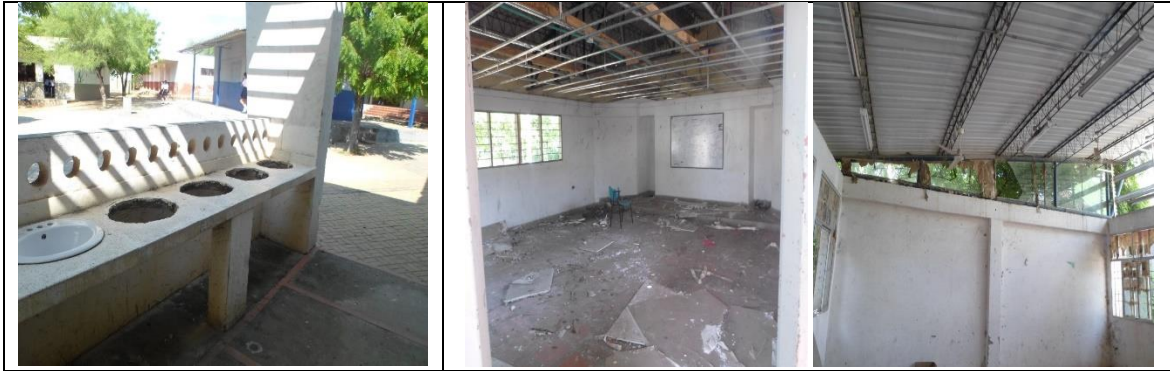
Fotografía 1. Estado actual Infraestructura Educativa.
