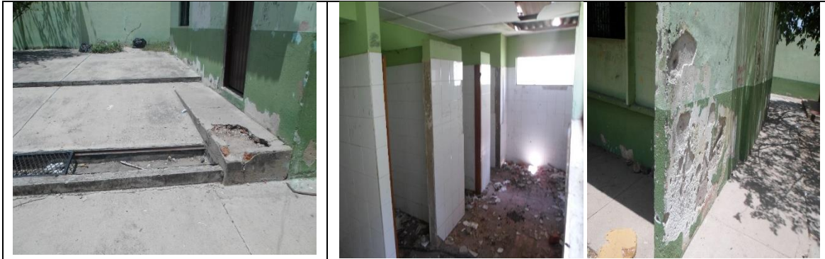
Fotografía 1. Estado actual Infraestructura Educativa.
