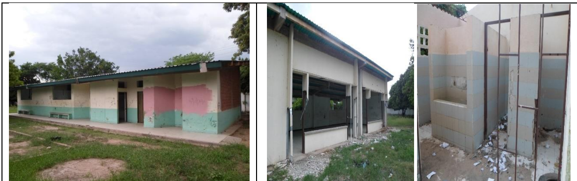
Fotografía 1. Estado actual Infraestructura Educativa.
