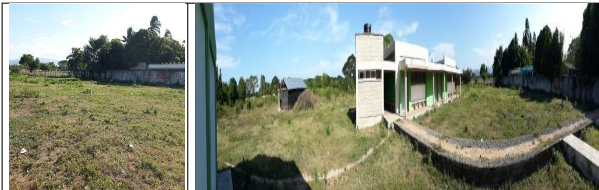
Fotografía 1. Estado actual Infraestructura Educativa.
