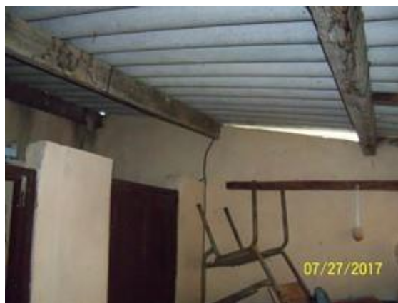
Área para rehabilitar o construir para el baño escolar, incluye la circulación cubierta
