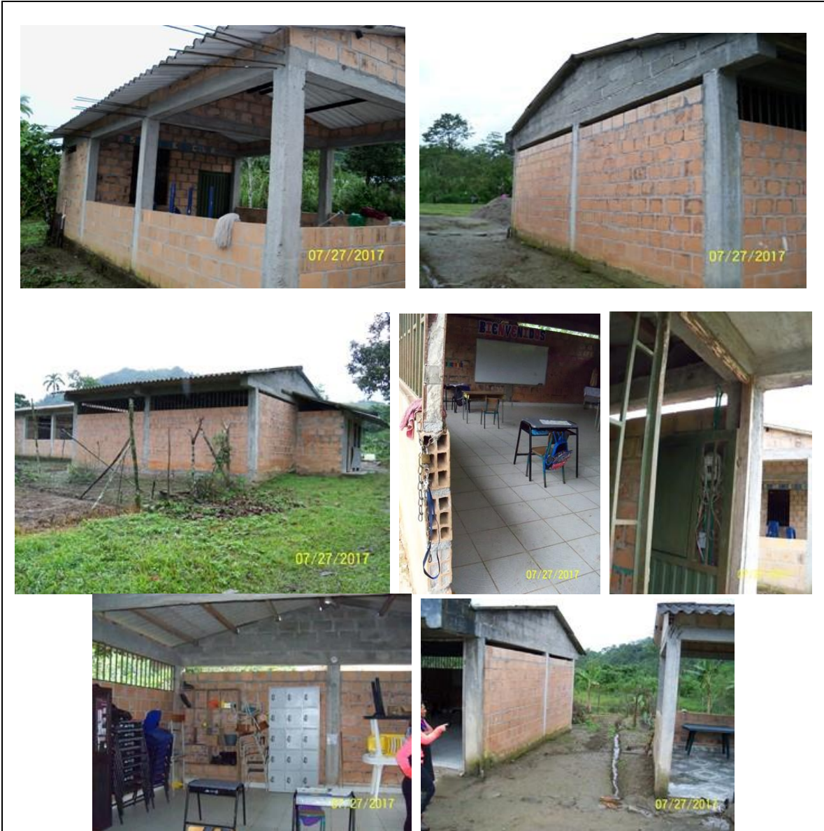
Modulo del acula escolar a intervenir y área de circulación existente.
