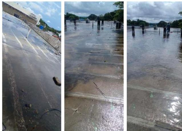
Evidencia de inundaciones en la cubierta del bloque
