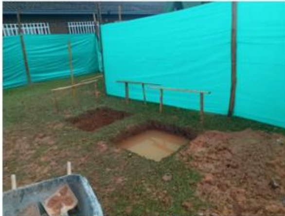
Foto 1. Excavación para zapatas llena de agua de lluvia
