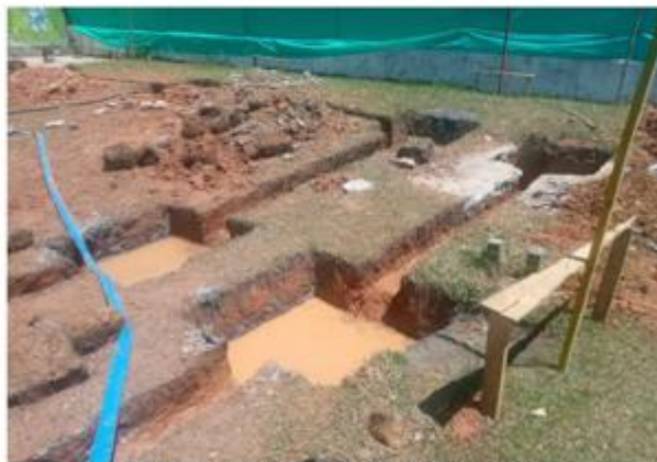
Foto 2. Excavación dados y vigas inundadas por lluvias
