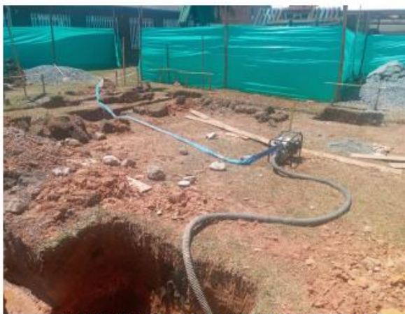
Foto 3. Evacuación de aguas de escorrentía localizada en excavaciones
