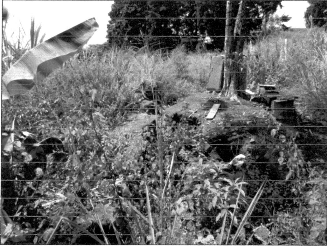
Imagen 3 Grietas de tracción a media ladera generadas por el proceso de remoción en masa.
