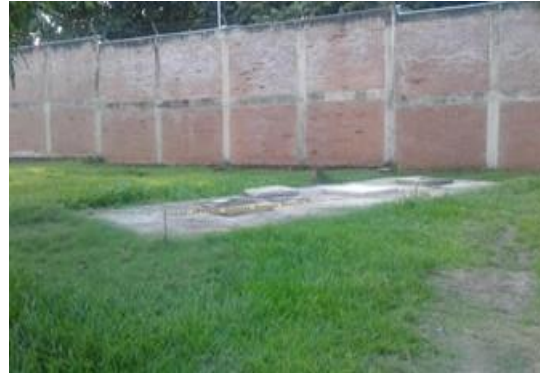
Pozo séptico existente, el cual se deberá dejar sellado y desconectado
