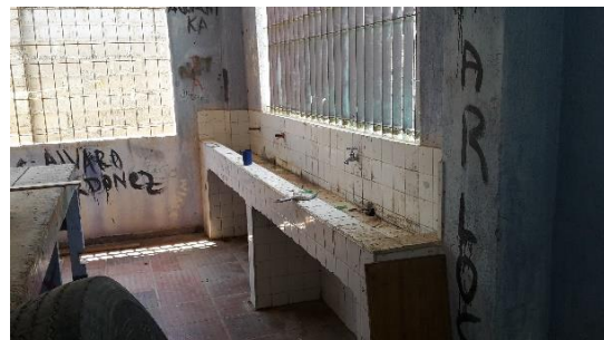
Estado actual lavadero ubicado el salón de carpintería
