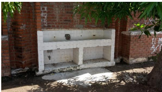
Estado actual lavadero ubicado en la cancha
