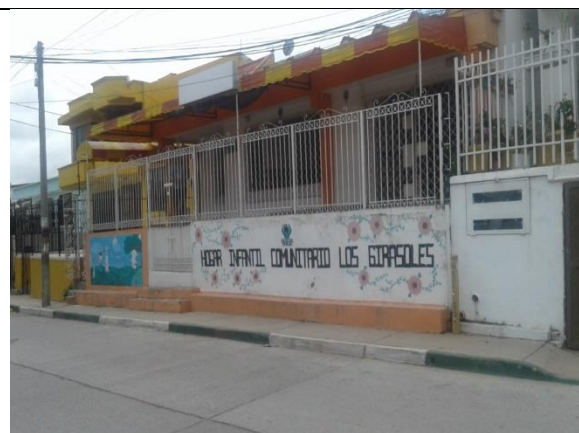
Fotografía 2. Edificación a demoler para desarrollar el proyecto.
