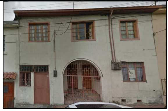
Fotografía 2. Edificación a demoler para desarrollar el proyecto.
