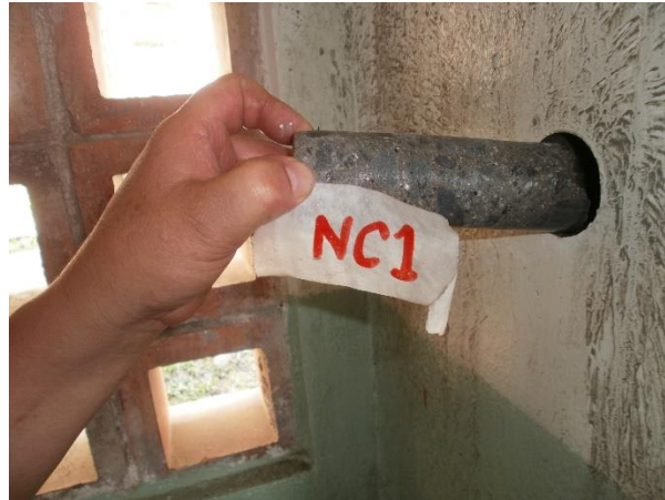
Figura 7. Registro fotográfico de Extracción de Núcleos
