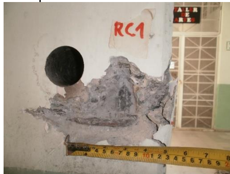
Figura 11. Regatas en elementos estructurales para identificar refuerzo
