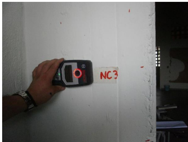
Figura 8. Registro fotográfico de scanner en elementos
