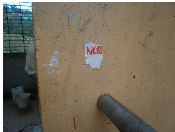
Figura 6. Registro fotográfico de Extracción de Núcleos
