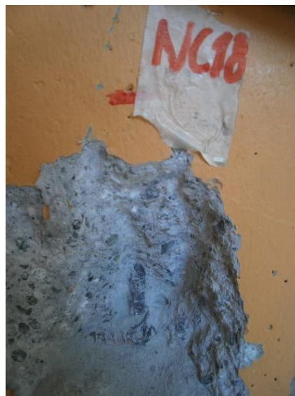
Figura 10. Regatas en elementos estructurales para identificar refuerzo
