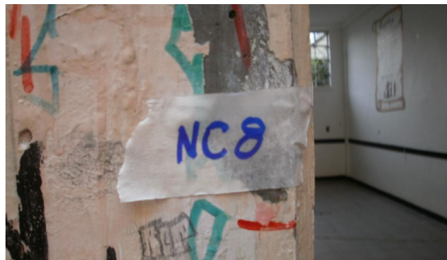
Figura 9. Registro fotográfico de Regatas en elementos estructurales
