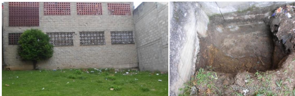
Figura 5. Registro fotográfico de Apiques
