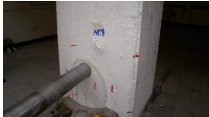
Figura 6. Registro fotográfico de Extracción de Núcleos
