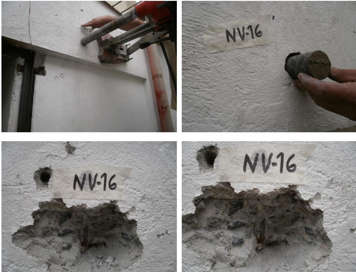
Figura 6. Fotos extracción de núcleo y regata en Viga
