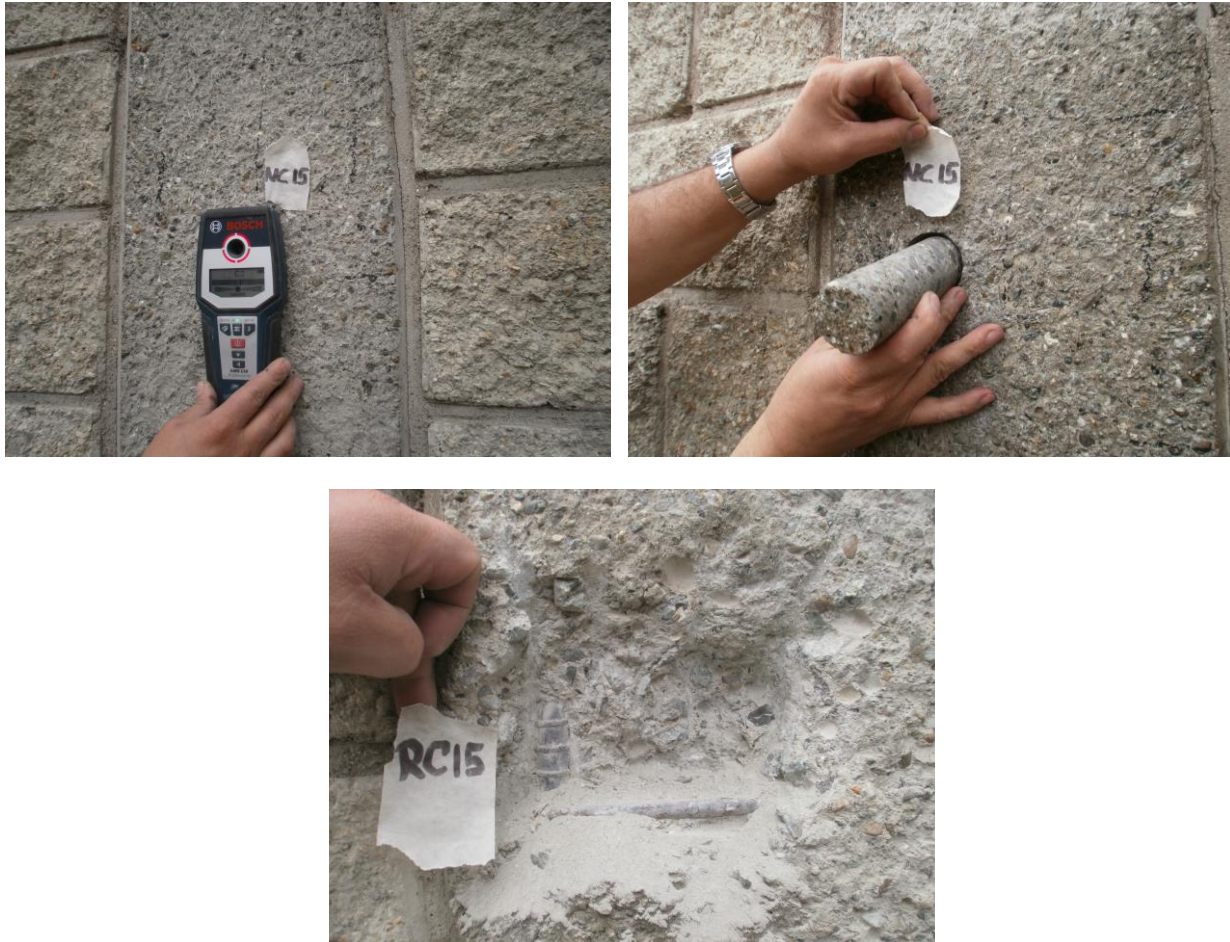
Figura 5. Fotos extracción de núcleo y regata en Columna
