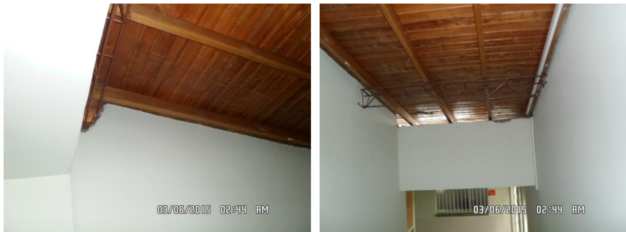
Figura 33. Fotos cubierta sobre escalera de conexión
