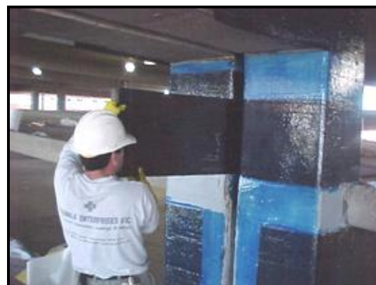
Figura 28. Reforzamiento de elementos estructurales con fibra de carbono
