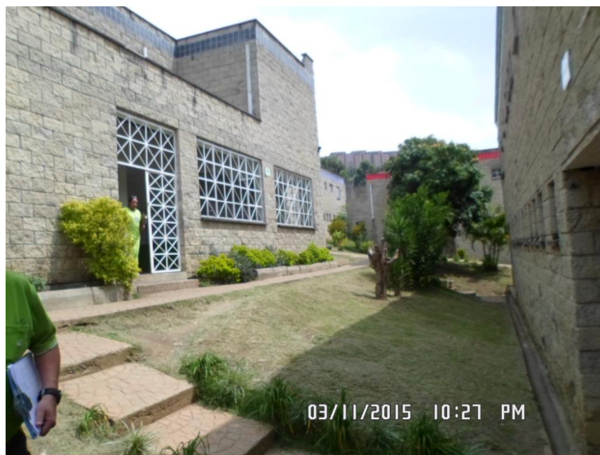
Imagen 9 Ingreso primer nivel
