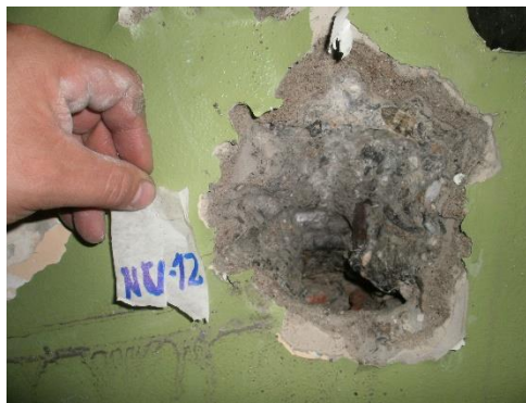
Imagen 13 Resultados de Ensayos – Regatas en elementos estructurales
