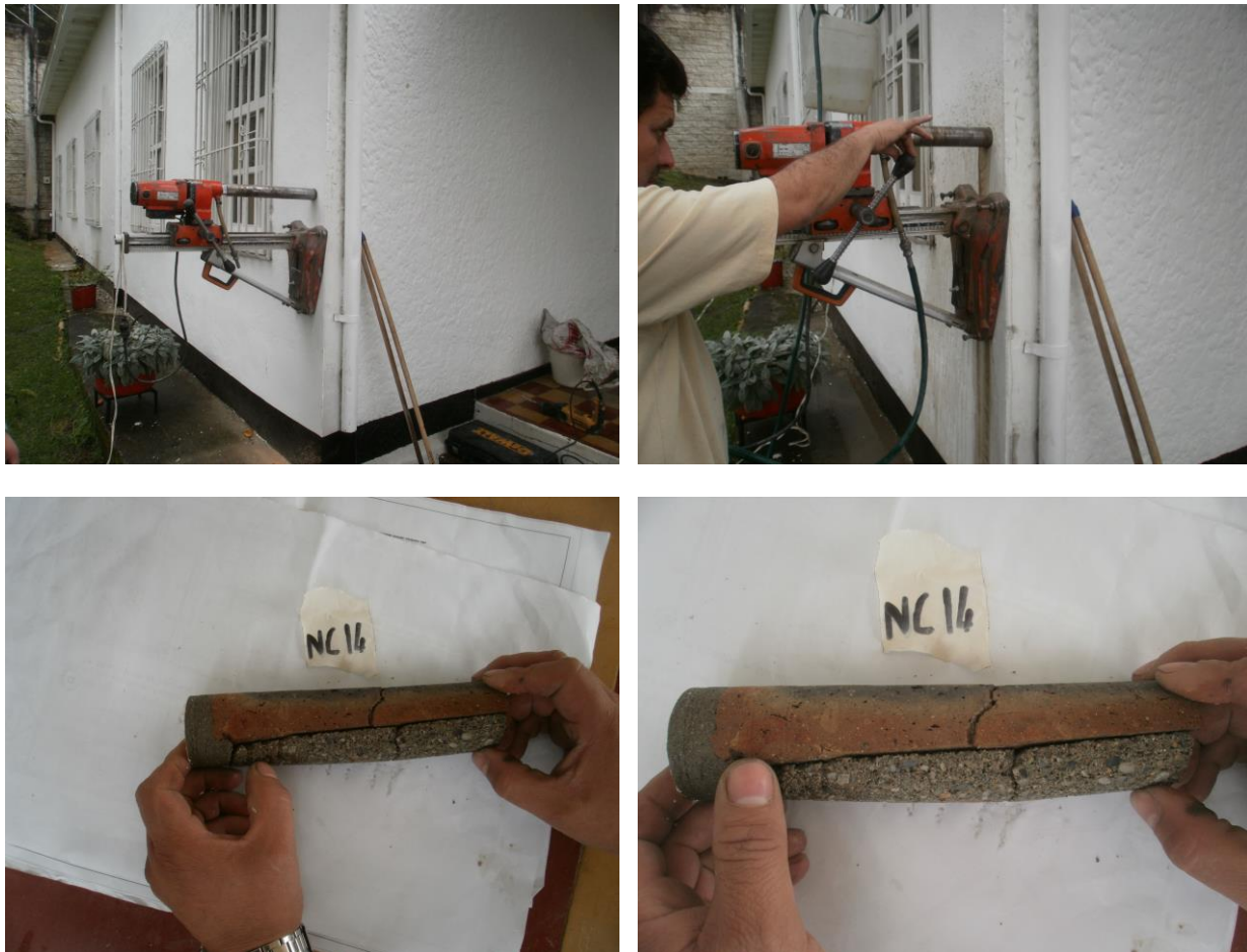
Figura 4. Fotos Extracción de Núcleo en Edificación CASA BLANCA
