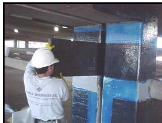
Figura 30. Reforzamiento de elementos estructurales con fibra de carbono
