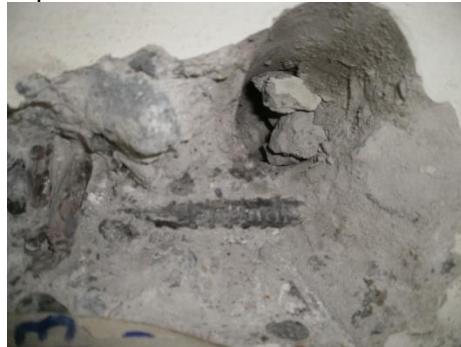
Figura 11. Regatas en elementos estructurales para identificar refuerzo
