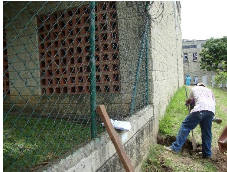
Figura 6. Registro fotográfico de Apiques
