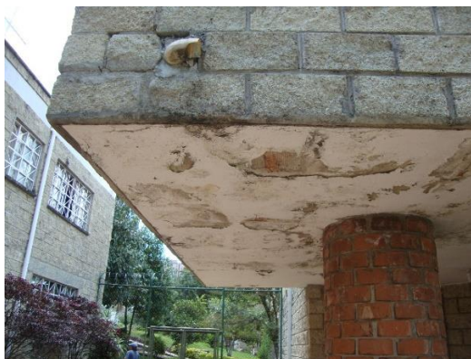
Figura 13. Fotos de cubierta en el acceso
