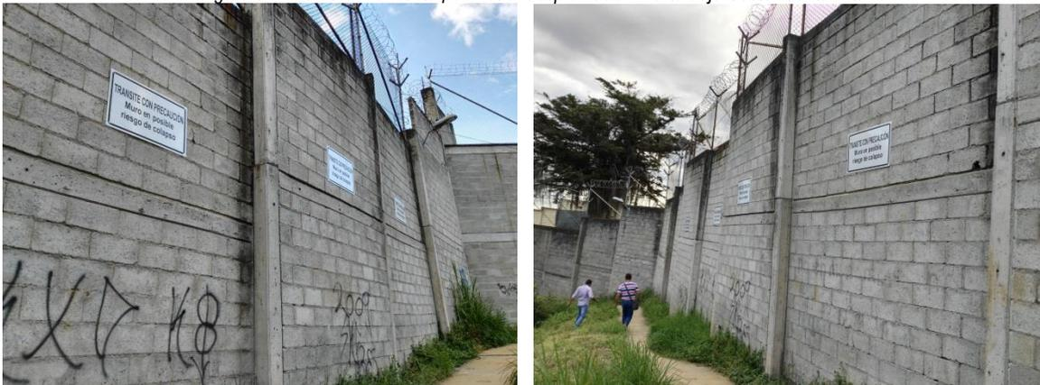
Figura 6. Tramos de muro de cerramiento perimetral desplomados.
