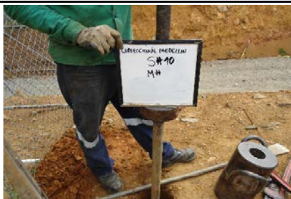
Fotografía 10. Ejecución Sondeo 10
