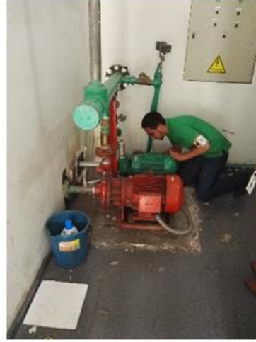
Sistema Hidroneumático
