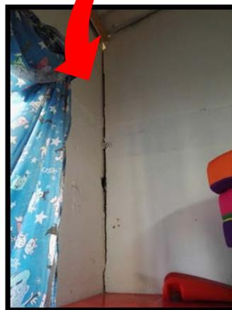
En la interseccion de estos dos muros se observa la grieta (lesion mecanica) por lo que estan completamente sueltos debido al cambio de rigidez ya que el muro divisorio es de 20 centimetros mientras que el de fachada es de 50 centimetros. Esta lesion se presenta por la falta de traba entre los muros, asi como la falta de confinamiento, lo que garantiza que trabajen de manera eficiente ante la accion de un sismo.
