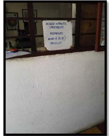
Las fisuras evidencian que se está presentando un asentamiento que está afectando la estabilidad de los muros.
