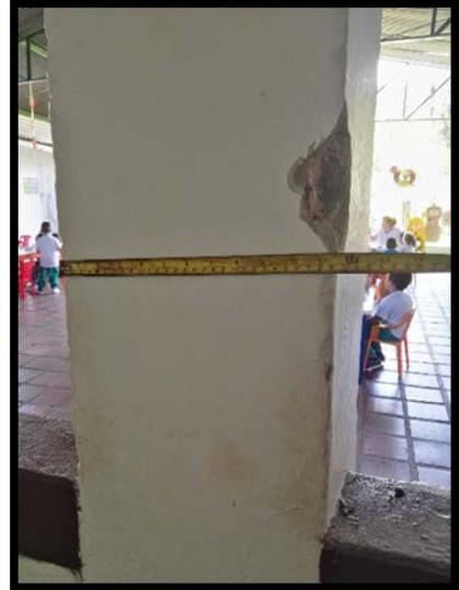
Al inspeccionar las columnas con el pachometro no se identificó acero de refuerzo ni longitudinal ni transversal en ellas. Sin embargo, mediante una regata se verifico que las columnas fueron construidas en ladrillo macizo.
