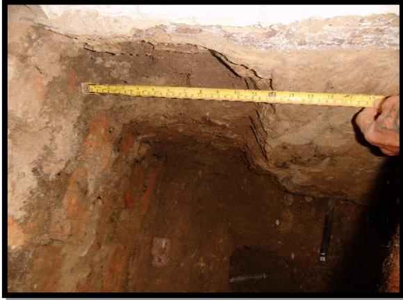
En la fotografía se observa que en este punto la cimentación es deficiente ya que no es continua, hay 30 centímetros de muro que está apoyado directamente sobre el suelo. Este muro tiene 75 centímetros de muro enterrado.
