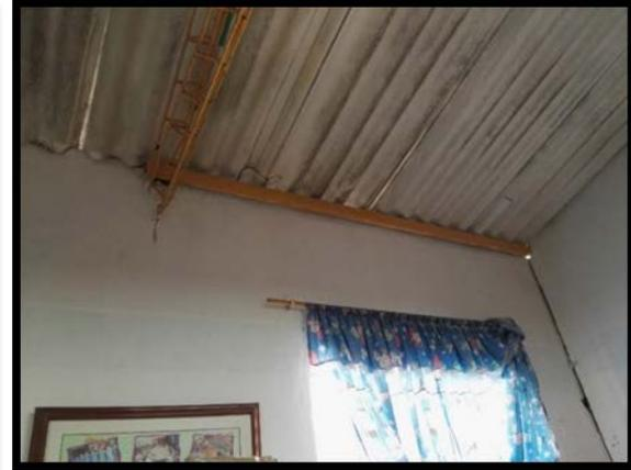
La cubierta es a dos aguas, esta compuesta por laminas de asbesto cemento (eternit) que descansan sobre cerchas en celosía que a su vez se encuentran apoyadas en los muros.
