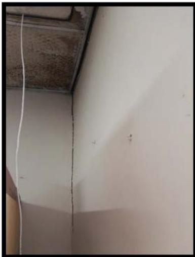
En esta zona se observan fisuras en la intersección de los muros debido a la falta de traba entre ellos y a la falta de elementos de confinamiento. Así mismo se observan las fisuras sobre la puerta debido a la ausencia del dintel para una puerta tan grande y el cambio en la sección del muro.
