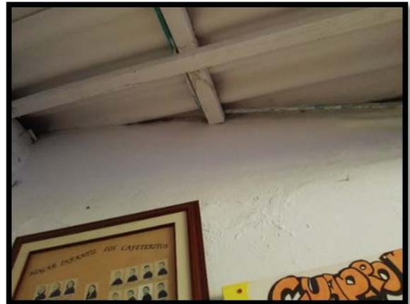
En la primera y segunda fotografía se observa como la canal (tubo PVC) recoge el agua de la cubierta y la conduce hacia el bajante. Sin embargo, el bajante es de menor diámetro que el de la canal que le entrega.
