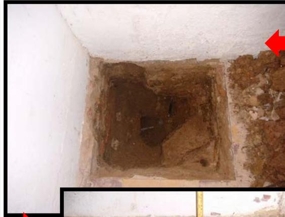
Se realizó un apique para revisar el tipo de cimentación de la edificación. Se excavo a un metro de profundidad hasta encontrar la profundidad de desplante de la cimentación.
