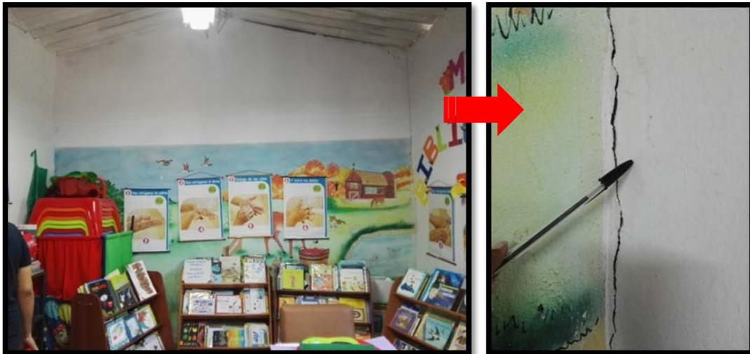
En la intersección de estos dos muro se presentan grietas y fisuras (lesion mecánica) debido al cambio de rigidez ya que el muro de la fachada es de 20 centímetros mientras que los otros muros son de 50 centímetros. El adelgazamiento de un muro en un mismo eje conlleva a la aparición de una fisura vertical entre ambos.
