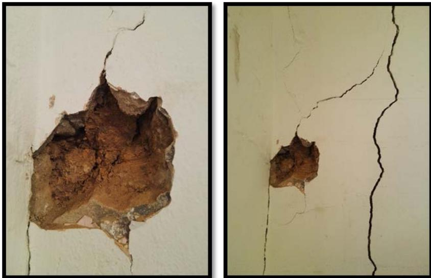
muro 2 (A-C) se inspecciono para conocer el material del que estaba compuesto el muro y se encontro un material arcilloso color ocre como se observa en la figura.
