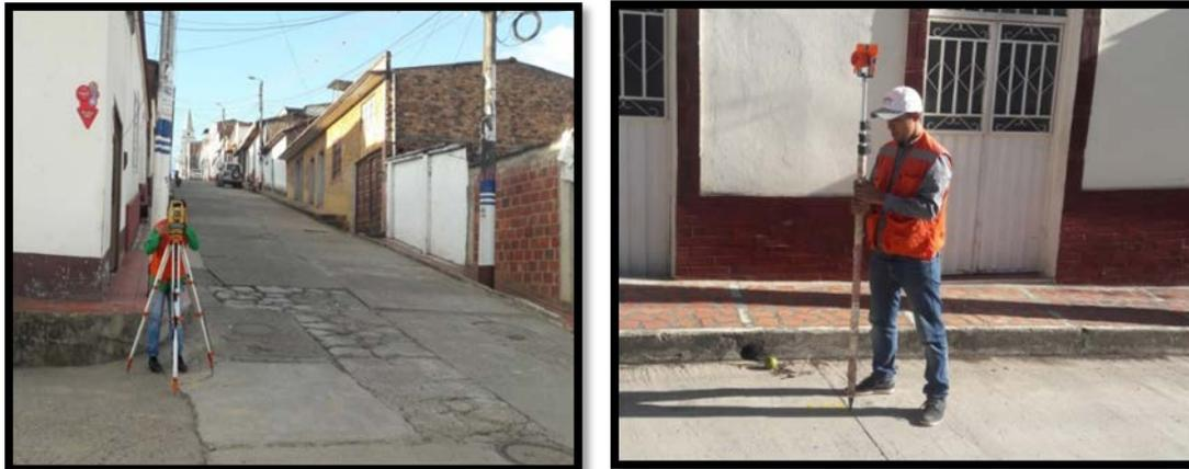
**Figura 12**Traslado de coordenadas por medio de poligonal abierta.
