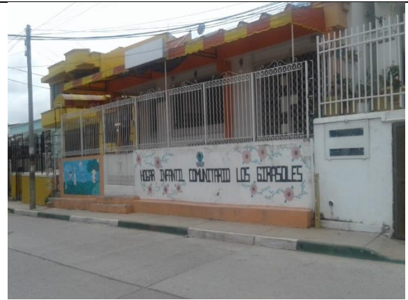
Fotografía 2. Edificación a demoler para desarrollar el proyecto.
