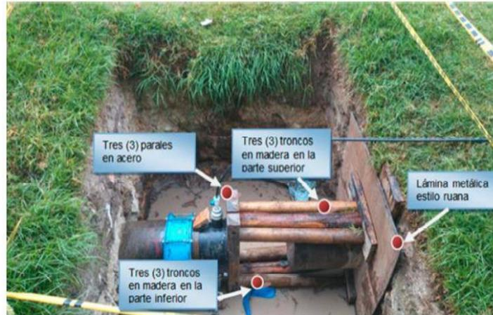
Figura 2. Ejemplo de anclaje temporal para Prueba CCP.
