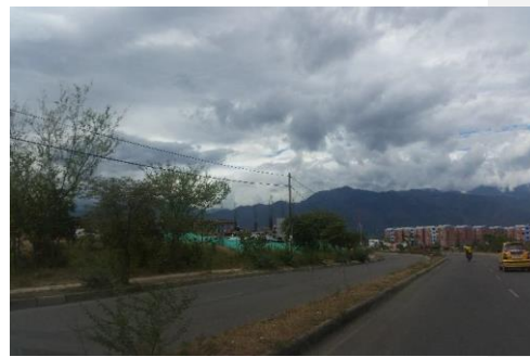
Carrera 33 vía principal de acceso costado sur
