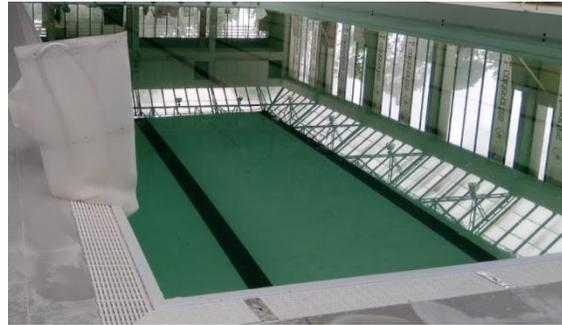
Otras actividades de construcción del vaso de la piscina son las siguientes. Escaleras, boquillas de impulsión, tomas de fondo, boquillas limpiafondos y membrana PVC recubrimiento piso piscina y tanque de equilibrio.
