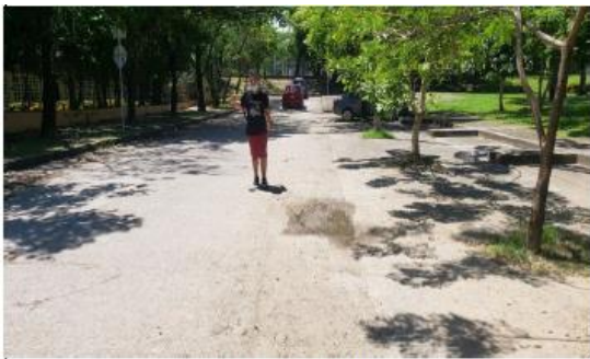
Vía Vehicular por el costado Oriente
