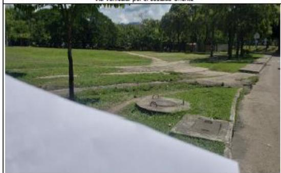
Cajas de inspección para recolección deguas lluvias y pozo de aguas residuales-costado Sur
