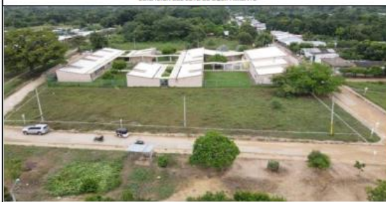
VISTAS AÉREAS GENERALES DEL LOTE PROPUESTO.
