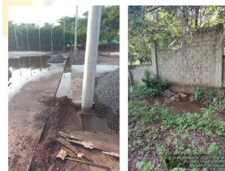
Ilustración 3. Taponamiento en canal natural
