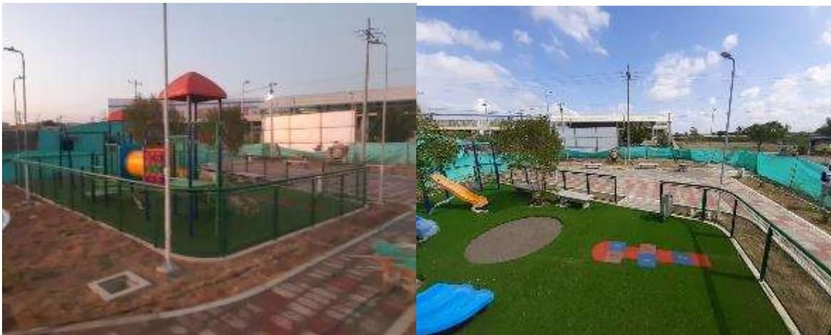
**15. Área de juegos infantiles terminada. Pisos instalado, cerramientos terminado y acabado en pintura de esmalte. Juegos de piso EPDM instalados. Arenero con punto sanitario y rejilla de cúpula. Módulos de juegos infantiles instalados y en buen estado.**
