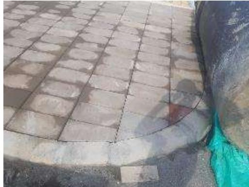
**Foto 17 y 18** corregir pegue en juntas entre sardineles prefabricados y emboquillado de adoquín en este sector.
