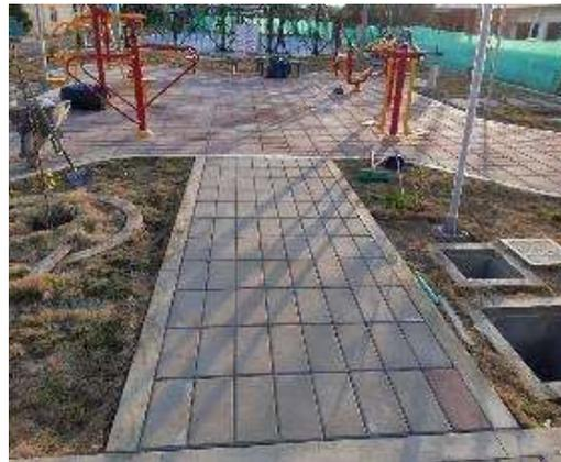
**26.** Vado en esquina del sector 2º en buen estado con pegues de los sardineles prefabricados sin detallar. Se deben detallar las juntas. Bordillo perimetral costado oriental del primer sector pendiente por aseo y limpieza general. Sendero adoquinado y confinado con bordillos y en lista de pendientes se muestran sectores con cambio de tono en el concreto.
