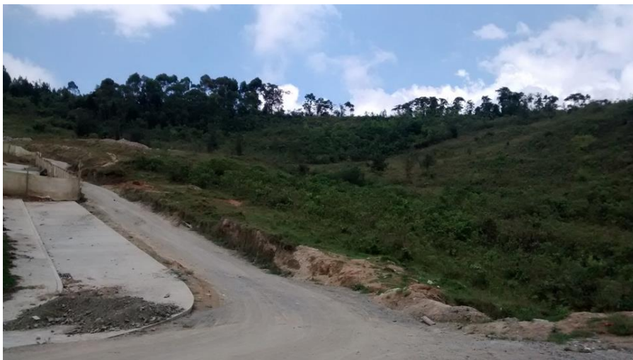
Figura 3 Localización de la zona de acceso al colegio
