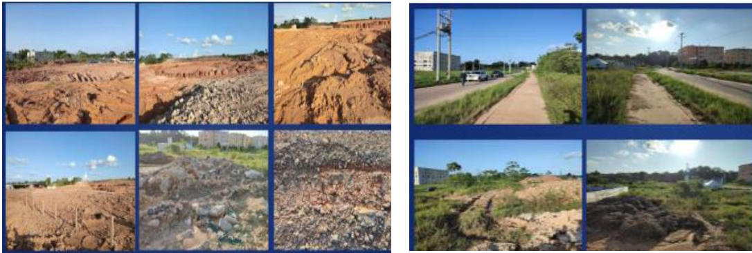
Fotografías. localización proyecto Urbanización Ciudad del Sol - Barrancabermeja
