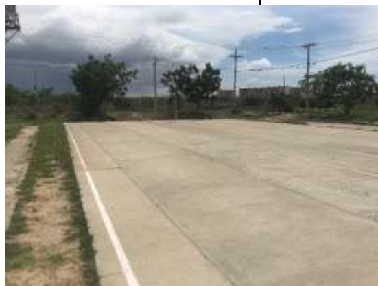
Fotografía 2. Vista general del predio
