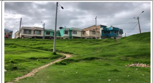
Redes de Energía Electrica en el predio
