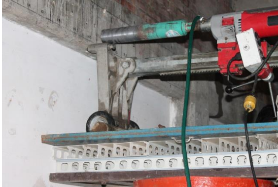
ILUSTRACIÓN 24. TOMA DE NÚCLEO N° 2 EN LA VIGA UBICADA EN EL EJE 3 ENTRE EJES D Y E, NIVEL 2.63M
