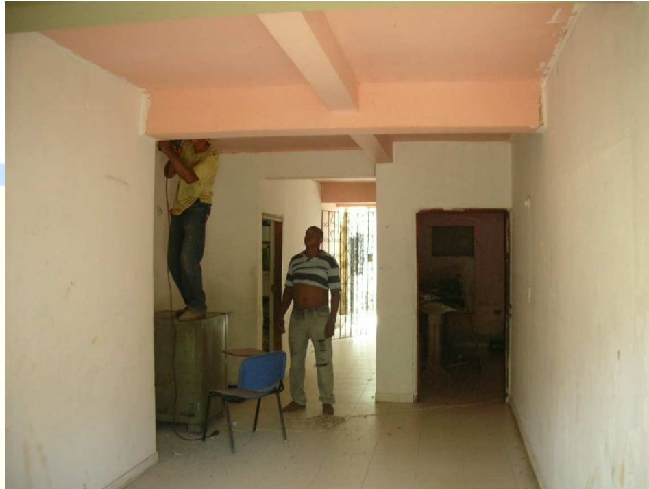
Fotografía No. 2 – Vigas y Viguetas Losa Entrepiso
