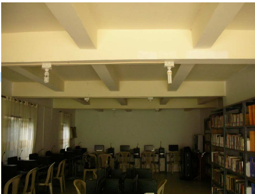
Fotografía No. 4 – – Entrepiso Biblioteca
