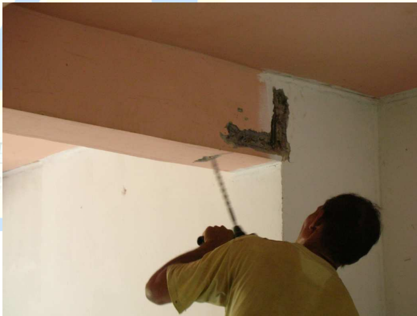
Fotografía No. 3 – Determinación de Ubicación y dimensiones acero de refuerzo
