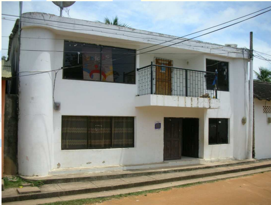
Fotografía No. 1 – Acceso Principal – Deterioro por falta de mantenimiento
