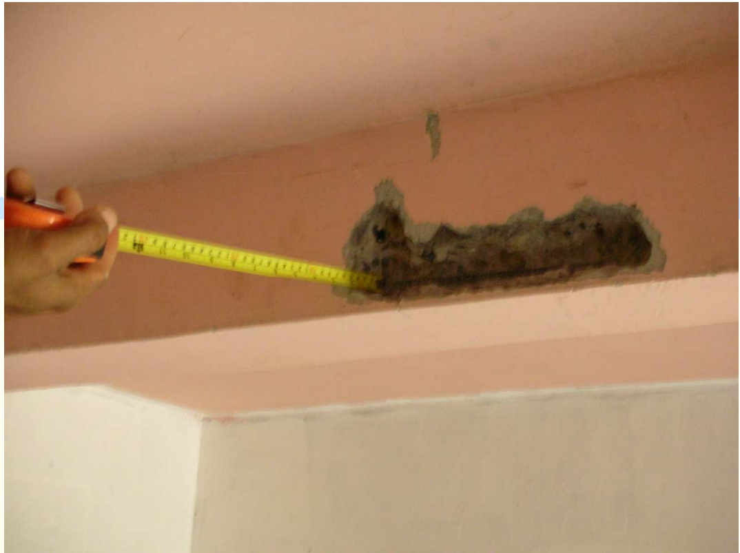
Fotografía No. 7 – Localización y espaciamiento armaduras
