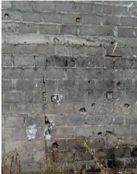
FOTO 7: Muro en mampostería.
