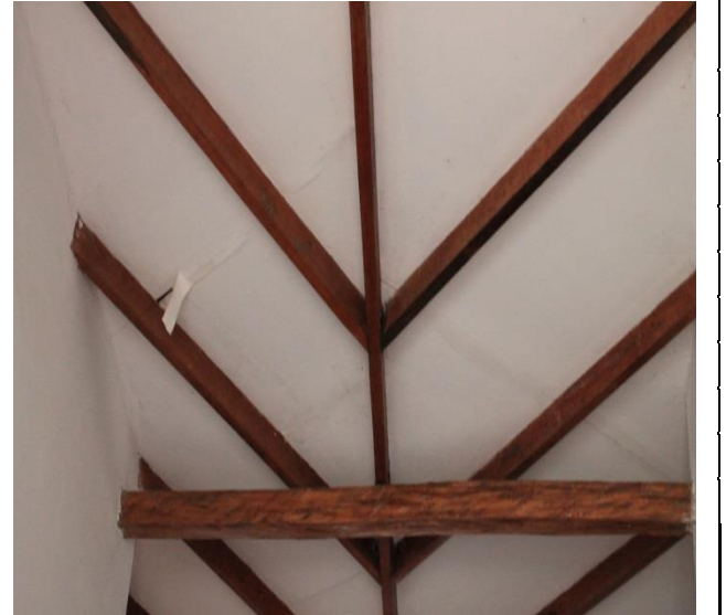
FOTO16: Cubierta con estructura en soporte de madera.
