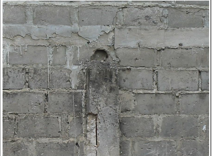
FOTO 8: Empalme viga con columna.
