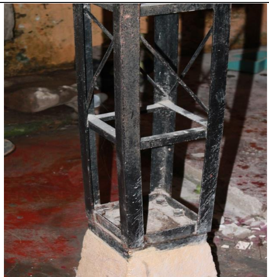
FOTO20: Detalle de pedestal en conexión con la estructura metálica que sostiene la cubierta del patio central.
