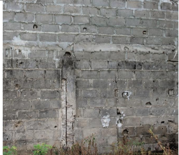
FOTO 6: Empalme viga sobre muro con columna
