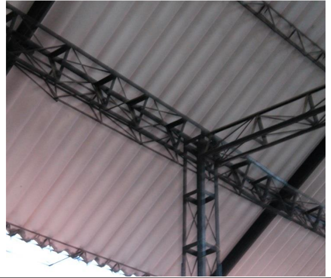
FOTO 18: Cubierta con soporte de cerchas metálicas en el patio central.
