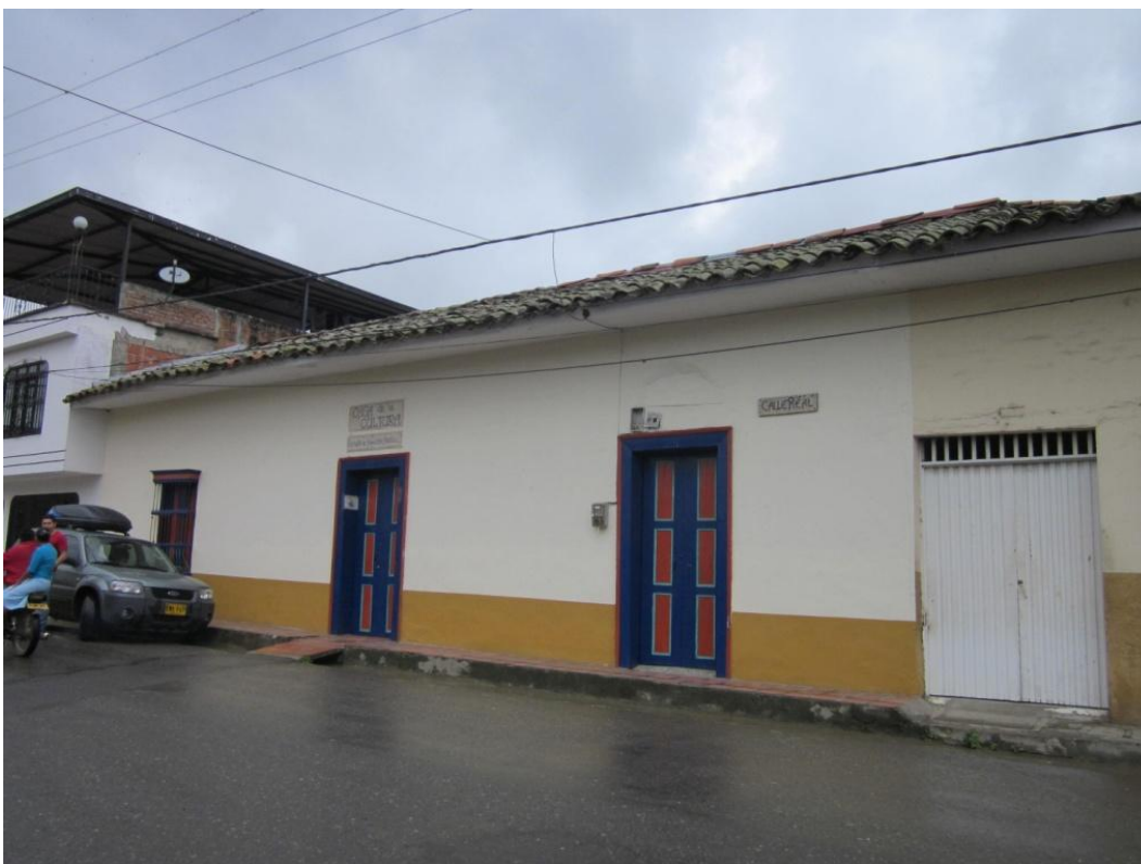
Figura 1. Vista general de la fachada del edificio
