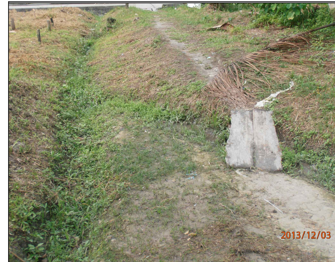
Drenaje de aguas lluvias
