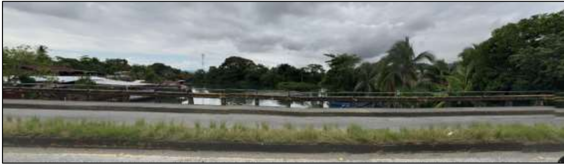
2. Puente y Canal de acceso rio Moin.
