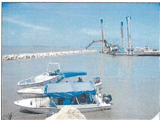
FOTOS 3 y 4. (I) Retroexcavadora 1800 en Espólón No 6. (D) Cuerpo del Espolon No 6 en sector Bocas de Ceniza.
