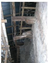
El espacio 4, configurdo con muros en ladrillo de barro, boveda en ladrillo macizo. El espacio presenta una falta de suelo, por derrumbamiento.
