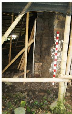
El espacio 3, ubicado hacia el occidente, alto deterioro, causado por condiciones climáticas, al no tener una cubierta adecuada queda expuesto a la intemperie lo que ocasiona pudrición de elementos de madera y deterioro del recubrimiento.
