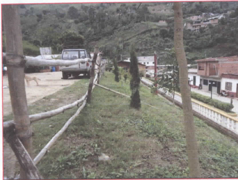
Fotografía 4. Muro y relleno en el sector oriental del lote.
