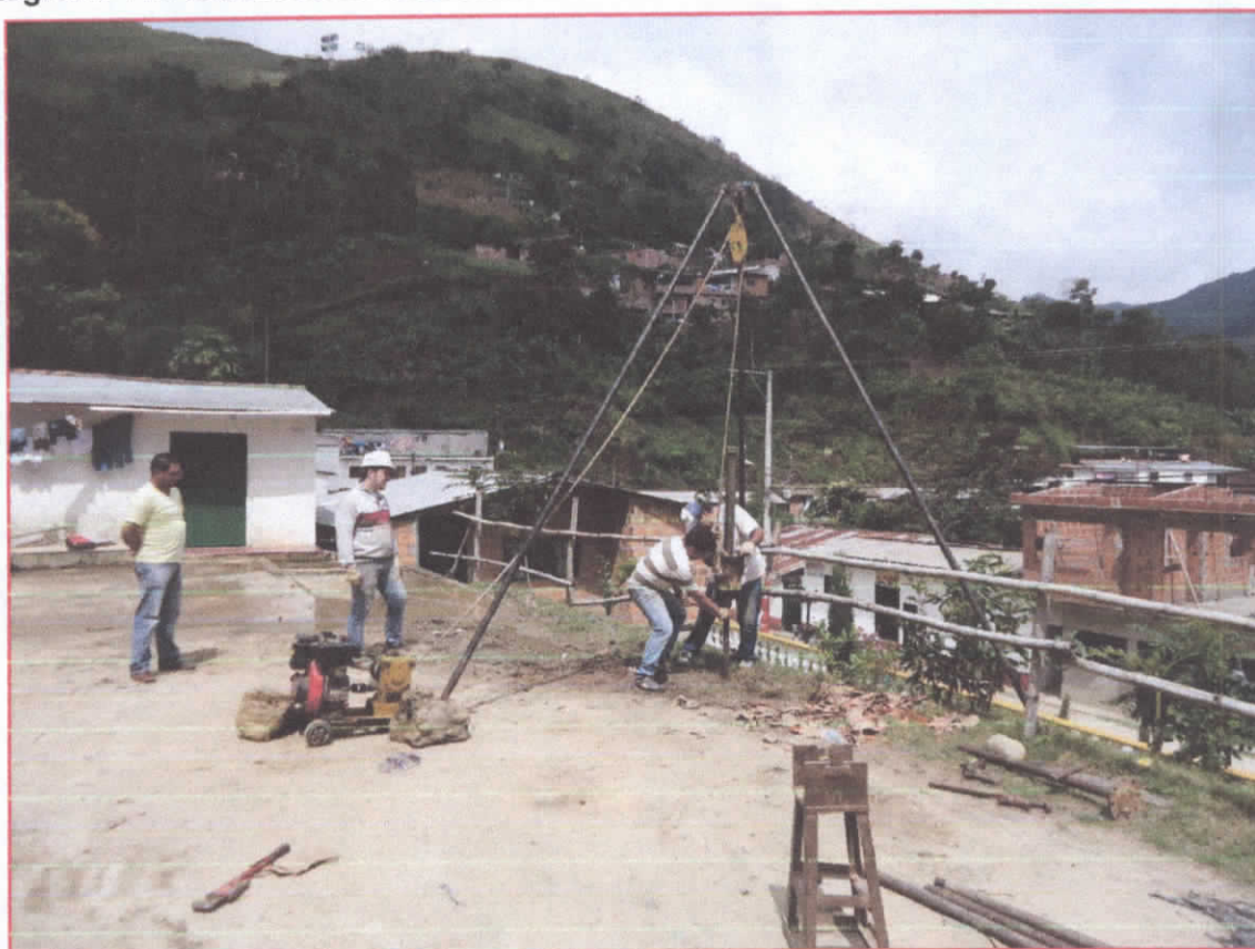
Fotografía 11. Realización Sondeo No. 2
