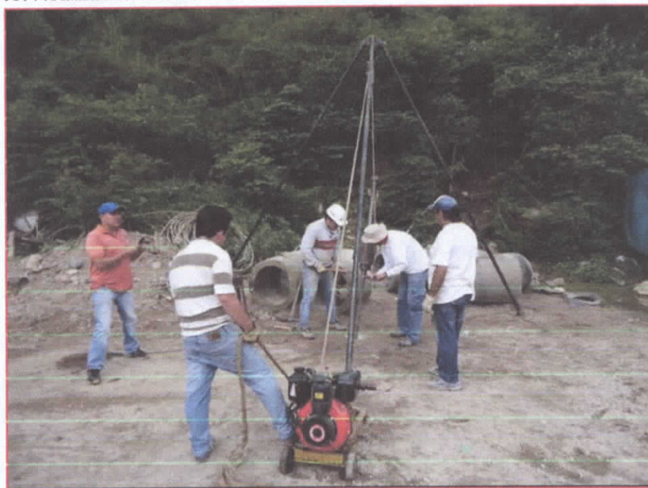
Fotografía 13. Realización sondeo No. 3.
