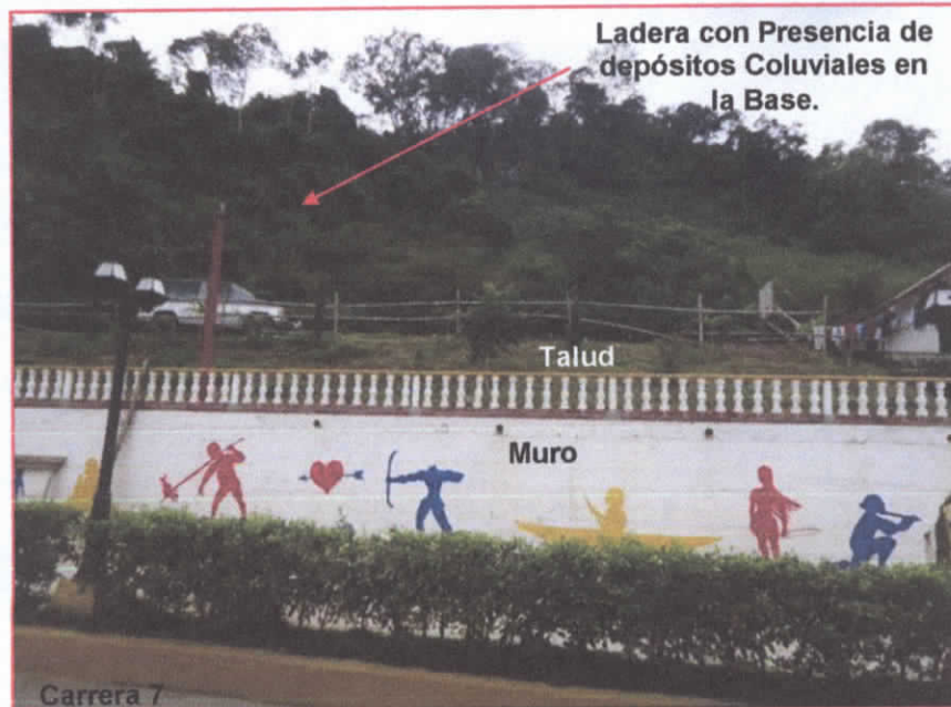
Fotografía 6. Ladera en el sector occidental del lote con proceso morfodinámico degradacional activo.
