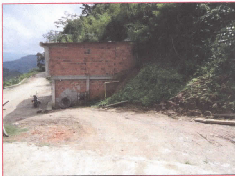
Fotografía 1. Ladera inestable sector occidental del lote.
