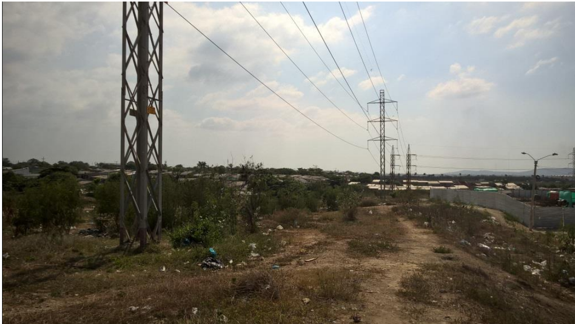
Figura 14. Predio para Biblioteca en Urbanización Gardenias
