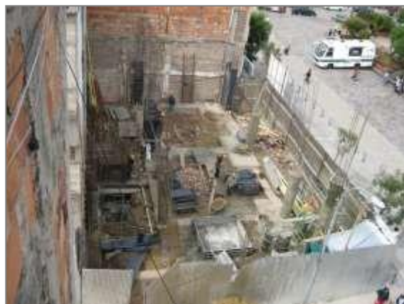
Fundición columnas nivel +0.00M.
