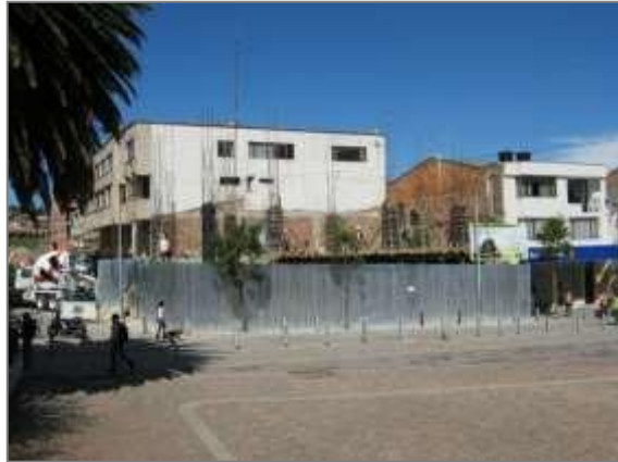
Fundición columnas nivel +2.94M.
