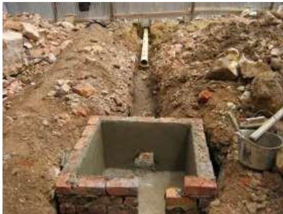
Excavación para acometidas sanitarias.
