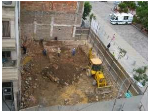
Excavaciones para cimentación.
