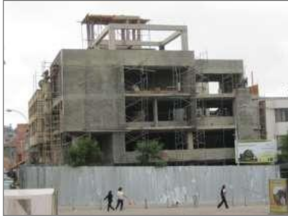
Pañetes externos fachada occidental.
