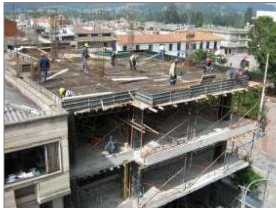
Amarre acero de refuerzo placa nivel +11.74M.
