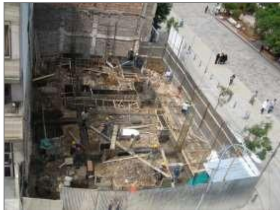
Amarre acero de refuerzo cimentación.
