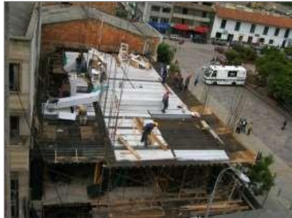
Amarre acero de refuerzo, tuberías y casetónplaca nivel +5.88M.
