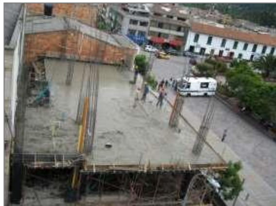
Fundición placa nivel +5.88M.
