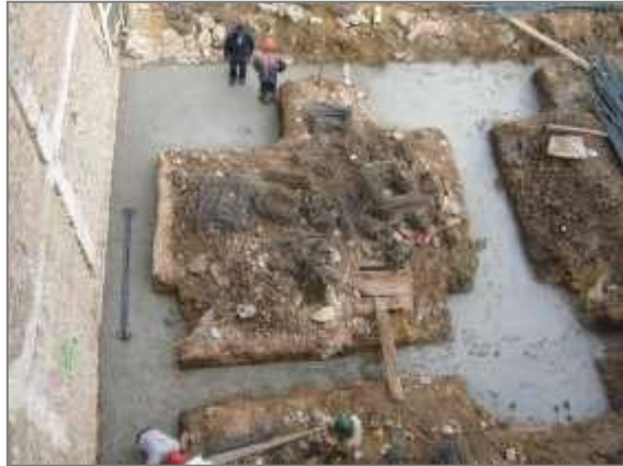
Concreto de limpieza.
