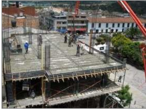
Fundición placa nivel +8.81M.
