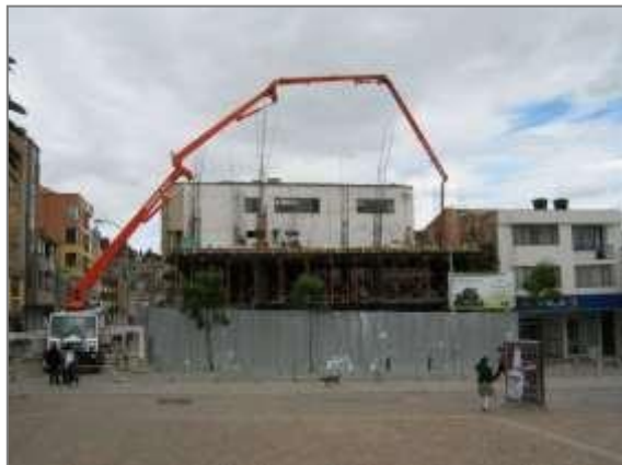
Fundición placa nivel +5.88M.
